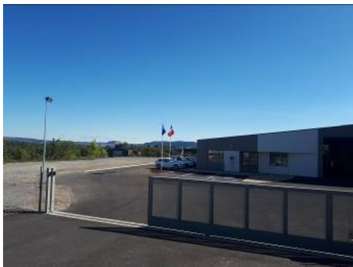
Bâtiment des Douanes, aujourd'hui
